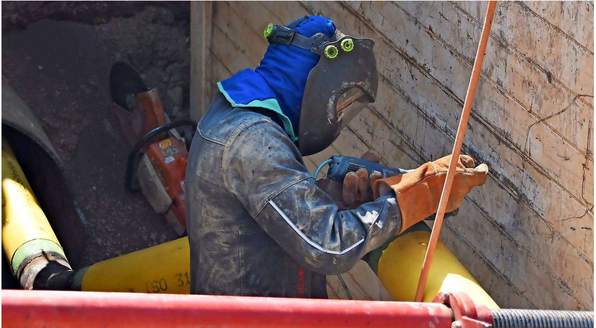
Wegen der Bauarbeiten ist auch der Radweg in Masholder derzeit gesperrt. Foto: TV/Christian Altmayer
