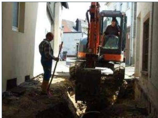
Nachdem zunächst in der Fußgängerzone gebaggert wurde, um von diesem Anschluss aus die neuen Kanäle und Leitungen zu verlegen, arbeiten Anton Pies (links) und Hans Georg derzeit im Durchgang zwischen Fußgängerzone und Kobenhof: Der Kanal ist bereits gelegt, die neuen Wasserleitungen folgen in Kürze. Insgesamt sollen die Arbeiten Ende Oktober abgeschlossen sein. (neb)/TV-Foto: Nina Ebner
