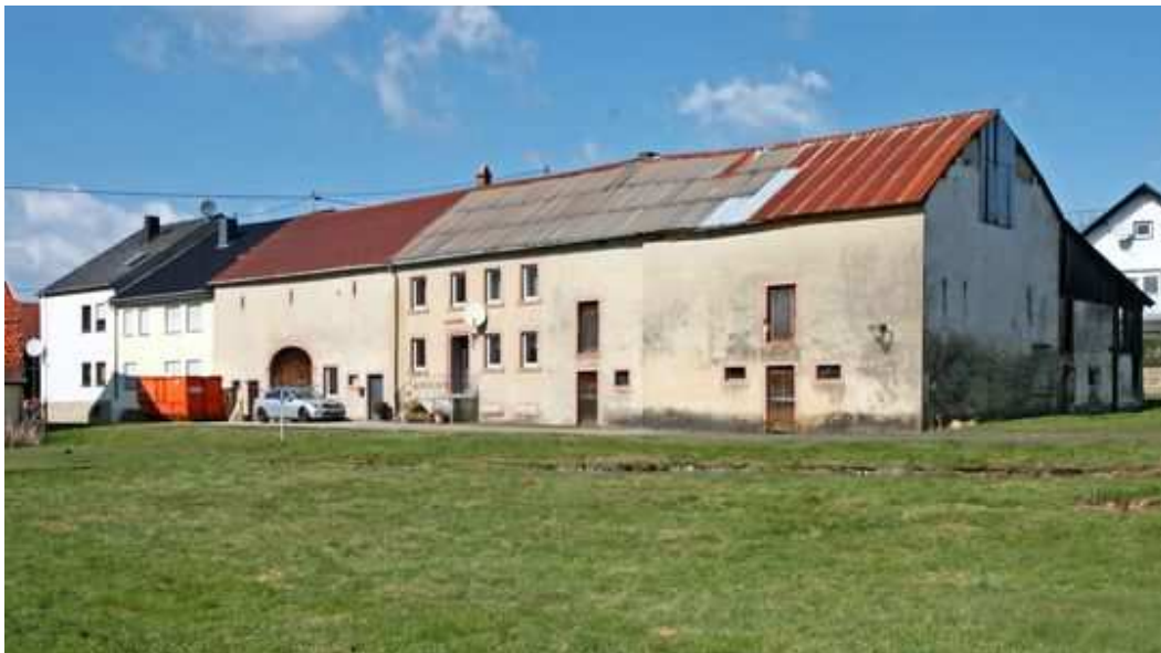
Anstelle des bäuerlichen Anwesens mitten in Badem soll eine Wohnanlage für Senioren entstehen. FOTO: Ortsgemeinde Badem / TV
