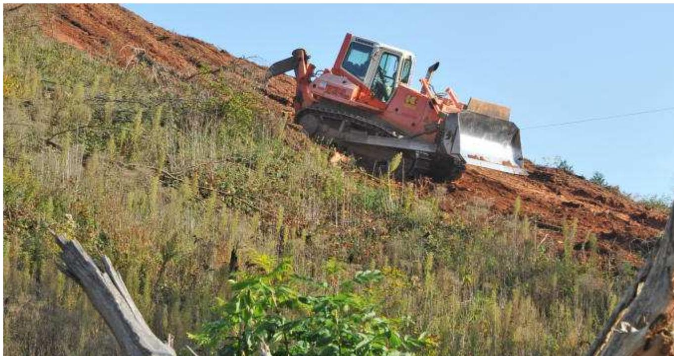
Rund eine Million Kubikmeter Erde wird dafür an der einen Stelle aufgeladen, um an einer anderen als Unterkonstruktion für die vierspurige Straße wieder eingebaut zu werden. Um diese Erdmassen bewältigen zu können, wird schweres Gerät eingesetzt. 2014 sollen die Baufahrzeuge abgezogen sein und der erste Abschnitt der Bundesstraße zwischen dem Kreisel bei Platten und der A 1/A 60 für den Verkehr freigegeben werden. (har)/TV-Foto: Klaus Kimmling
