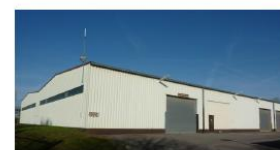
Foto: ehemalige Fahrzeughalle
