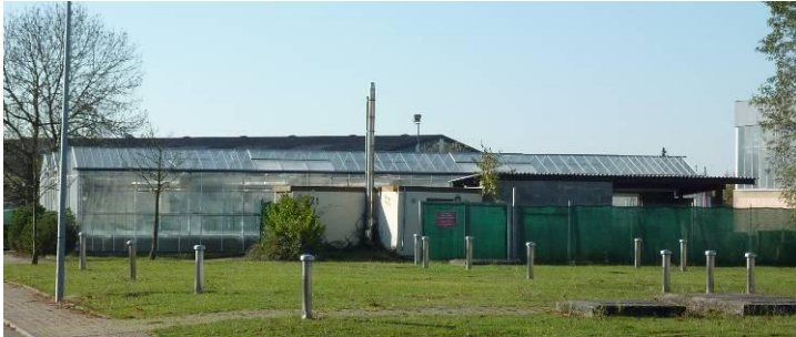
Abbildung 42: Lage des unterirdischen Regenrückhaltebeckens nordöstlich des Gebäudes 2022
