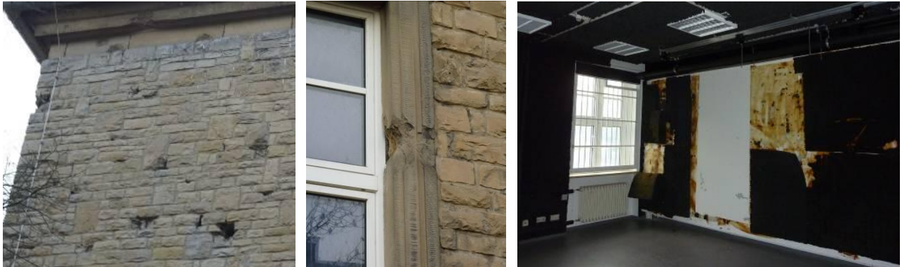
Abbildung 24, Abbildung 25 und Abbildung 26: Bauschäden am und im Gebäude 2011
