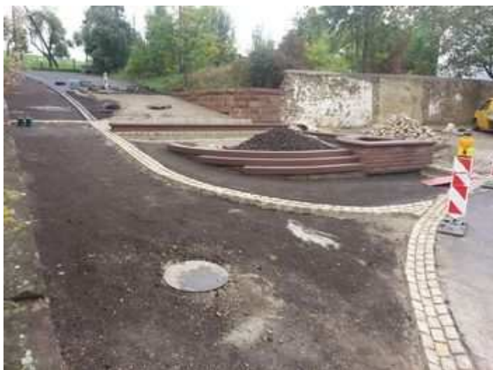
Der neue Kirchplatz ist fast fertig.
