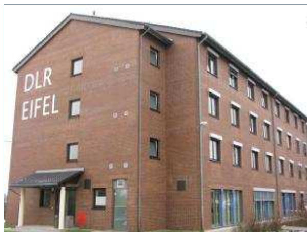
Das Problem-Gebäude am Flugplatz. TV-Foto: Katharina Hammermann
