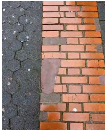
Abbildung 54, 55 und Abbildung 56; bauliche Schäden des Pflasters in der Fußgängerzone
