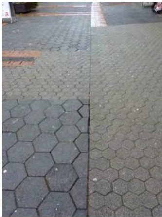
Abbildung 54, 55 und Abbildung 56; bauliche Schäden des Pflasters in der Fußgängerzone
