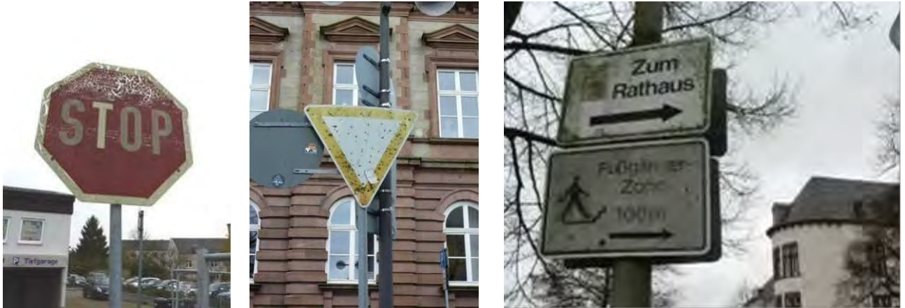
Abbildung 93, 94 und Abbildung 95: erneuerungsbedürftige Verkehrszeichen und Wegweiser
