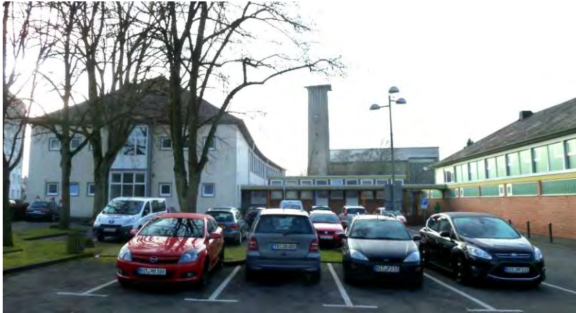
Abbildung 43: Gebäude der Grundschule Süd; Schulgebäude (links) und Turnhalle (rechts)
