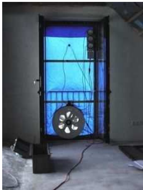
Apparatur zur Luftdichtheitsmessung
