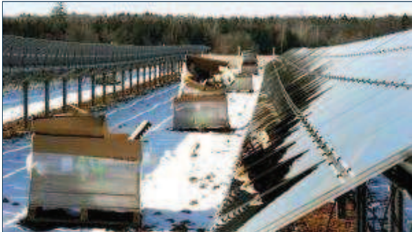
Eine Solaranlage wie diese in Niederöfflingen soll auch am Bitburger Flugplatz entstehen. TV-Foto: Archiv/Klaus Kimmling
