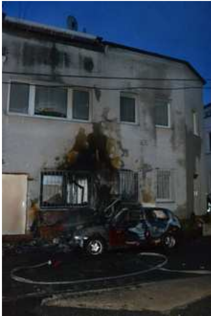
Foto von der Brandstelle
