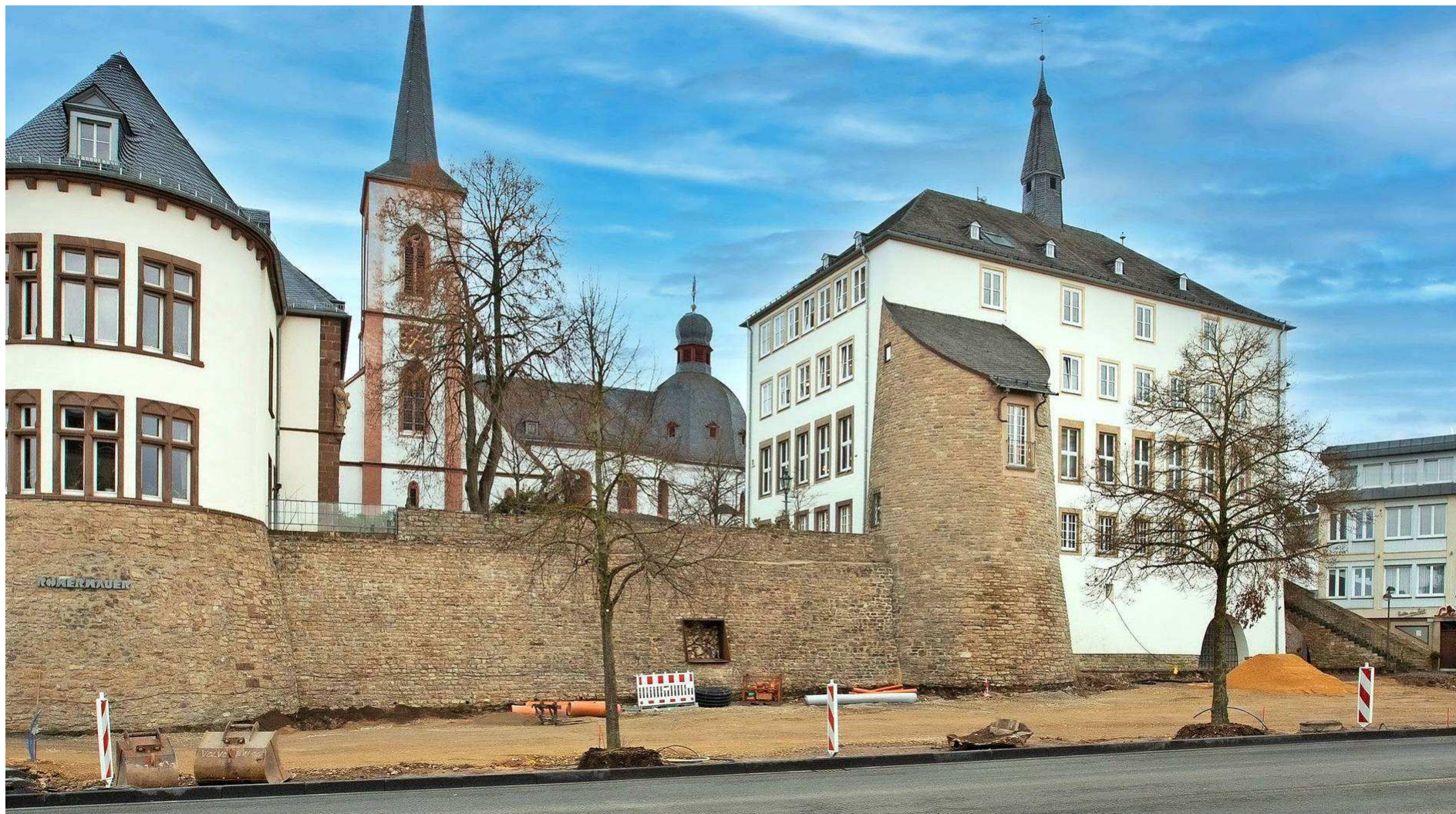
Bitburg - Die Bauarbeiten am grünen See im November 2020 Foto: Rudolf Häfner
