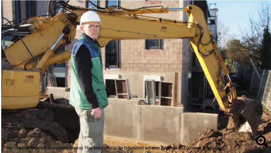
Foto: Christian Moeris Grabungsleiter Marcus Thiel beaufsichtigt die Erdarbeiten auf einer Baustelle im Görenweg in Bitburg
