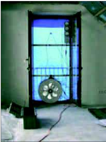
Apparatur zur Luftdichtheitsmessung
