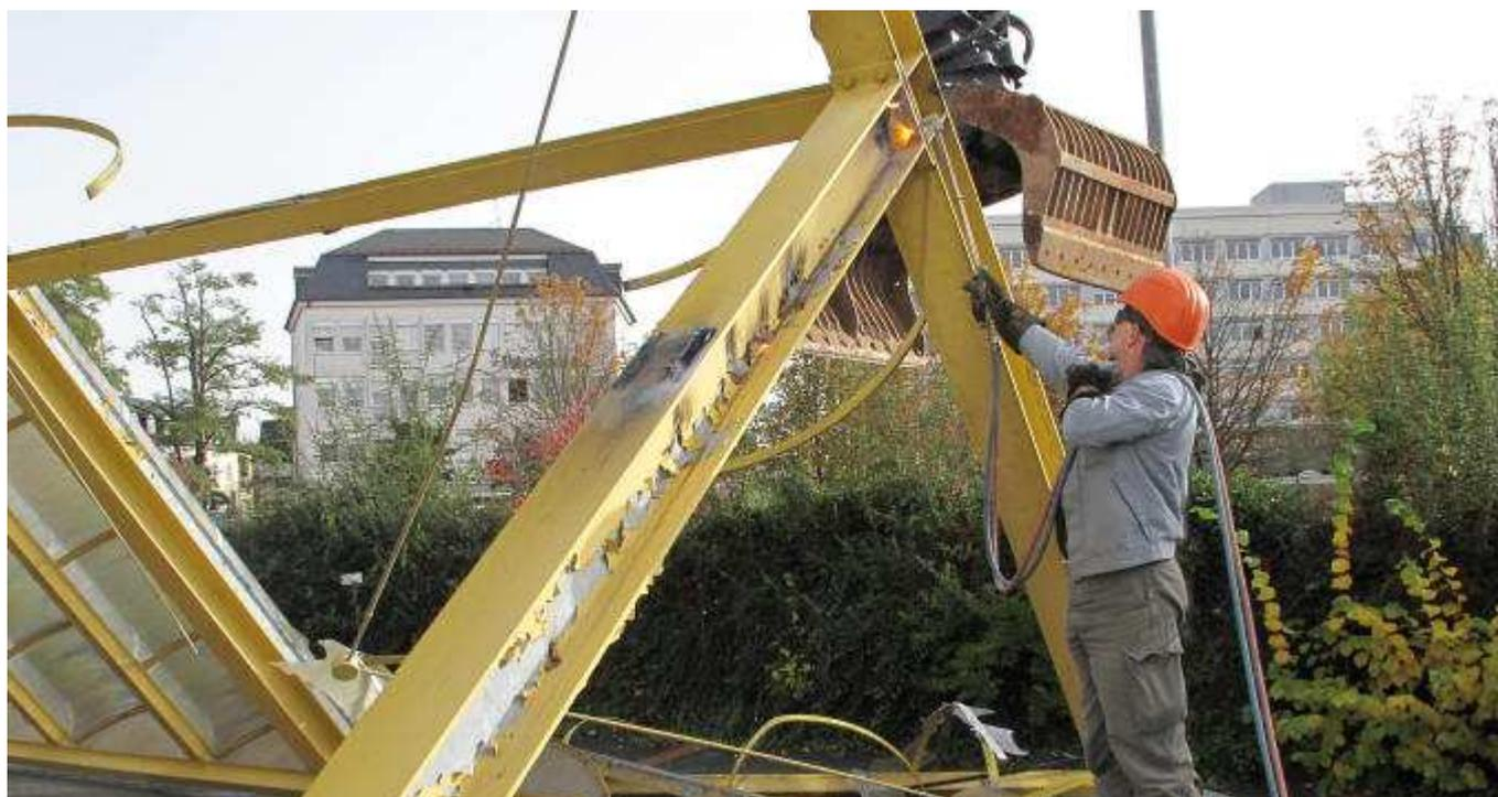
Weg mit dem Dach: Ein Arbeiter erhitzt die Metallstreben, damit diese mit der Baggerschaufel leichter zu zerlegen sind. So wurde gestern immer wieder geschweißt, abgerissen und zerlegt, bis am Nachmittag von dem Dach am Postgebäude nichts mehr übrig war. TV-Foto: Dagmar Schommer
