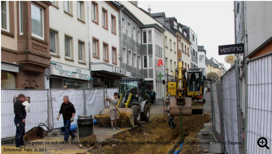
Stück für Stück graben sie sich voran: Bauarbeiter schaufeln Sand unter die neue Wasserleitung in der Fußgängerzone. TV-Foto: Dagmar Schommer Foto: (e\_bit)
