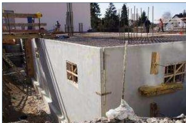
Auf dem Baugelände der Galerie Pierre wird alles für die Kellerdecke vorbereitet, die morgen betoniert werden soll.
