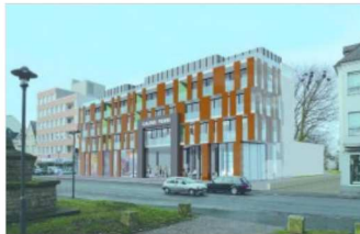
Mitten in der Bitburger Innenstadt, an der Trierer Straße, entsteht die Galerie Pierre. Bild: HGH
