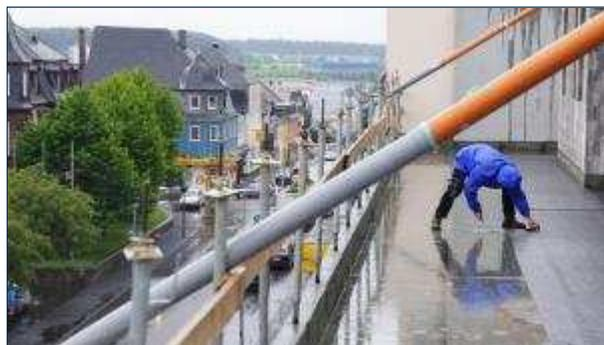
Nachdem der Rohbau der Galerie Pierre fertig ist, laufen nun die weiteren Arbeiten auf Hochtouren. Das gilt auch für die Vorbereitungen für den künftigen Ablauf des Regenwassers, das derzeit über ein Rohrprovisorium nach unten gelangt.
