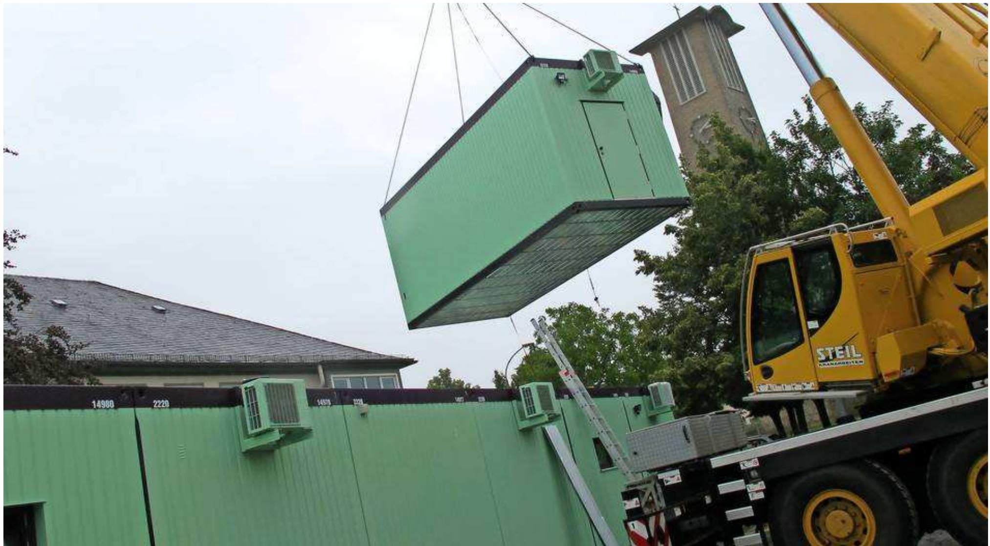
Grundschule Süd Südschule Bitburg Container Foto: TV/Dagmar Dettmer
