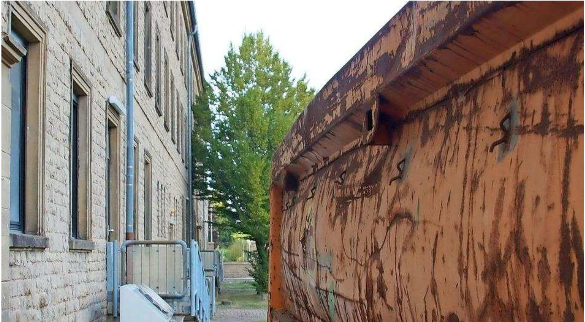
Die Umnutzung des ehemaligen Kasernenblocks 2001 als Kita ist vor Ort eine Baustelle und im Rat eine Dauerbaustelle. Foto: Uwe Hentschel
