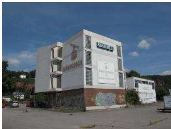
Die Talstation der Kabinenbahn am Trierer Moselufer. Seit vielen Jahren gammelt der Bau vor sich hin.
