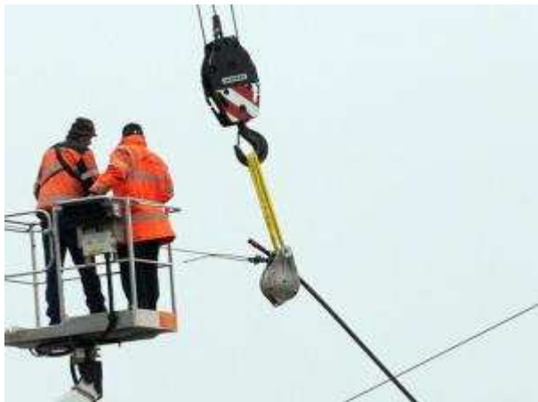
Abbau der Stahlseile der Kabinenbahn durch eine Spezialfirma aus Österreich. Die B 53 war in Trier-Pallien gesperrt.
