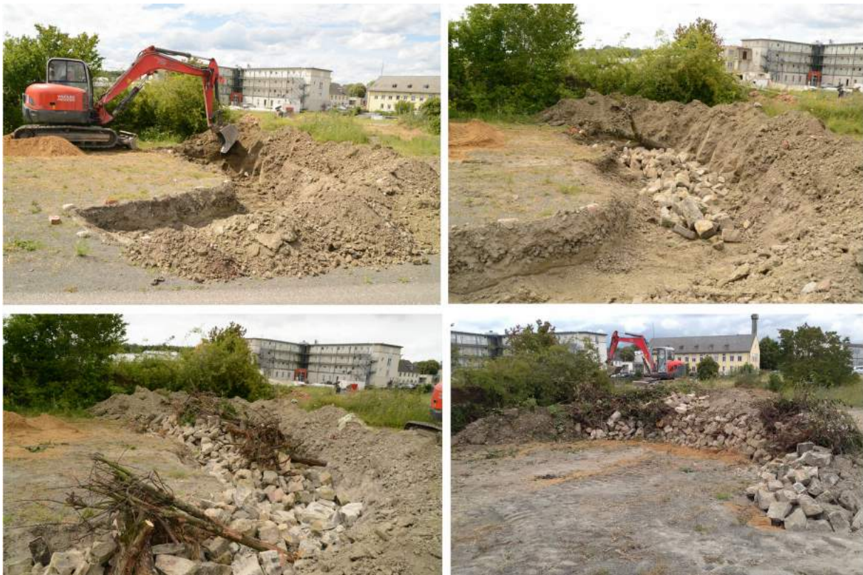
Abbildung 5: Errichtung des Steinriegels am 9. und 10. Juli 2020.
