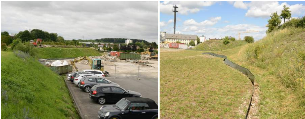
Abbildung 7: Verlauf des Zauns zur Baufeldsicherung.
