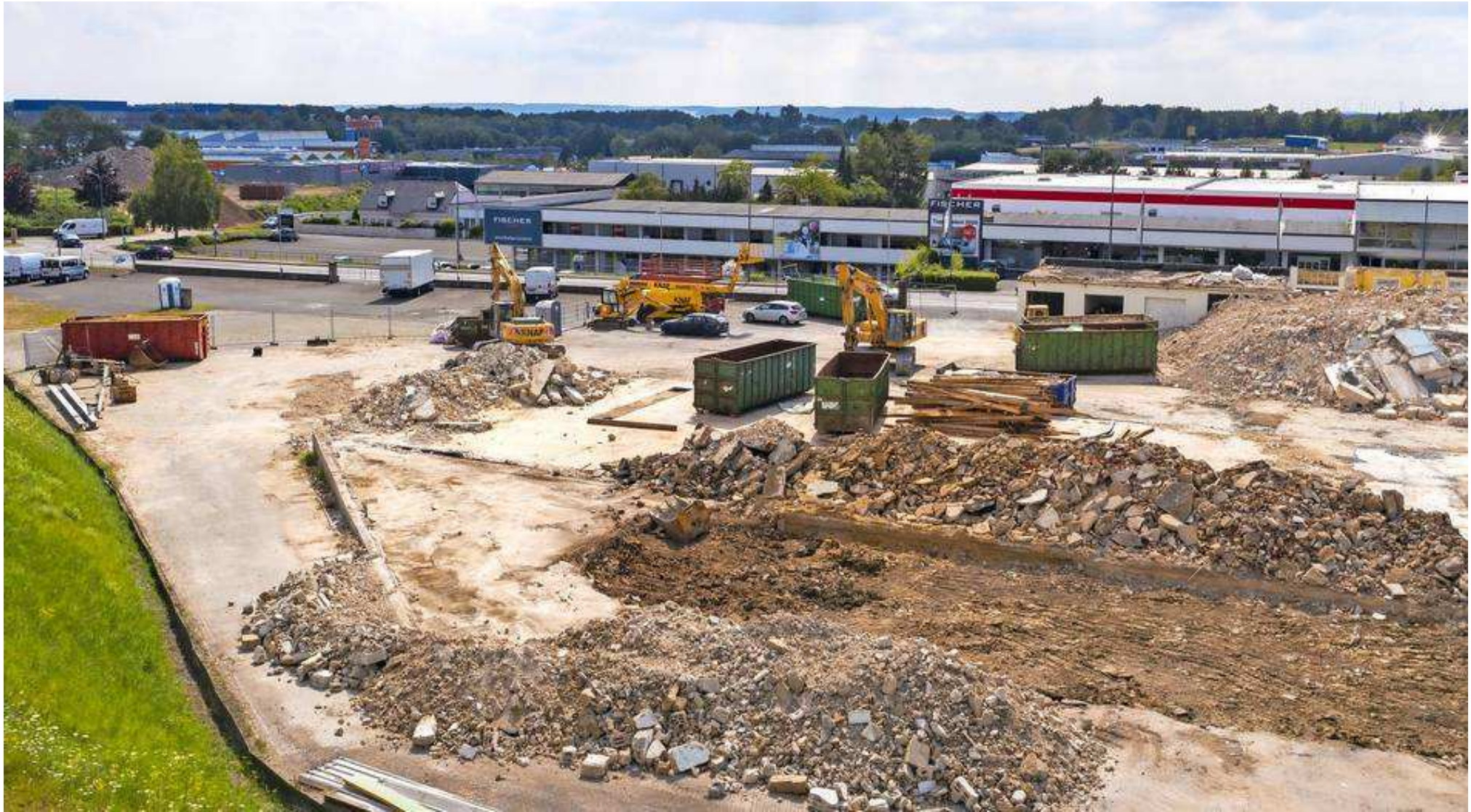
Bitburg Baustelle Gangolf Saarstraße Foto: Rudolf Häfner
