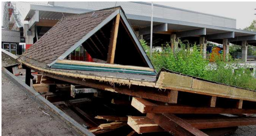
Dachschaden: Vor der Bitburger Eishalle am Südring liegen die Reste
