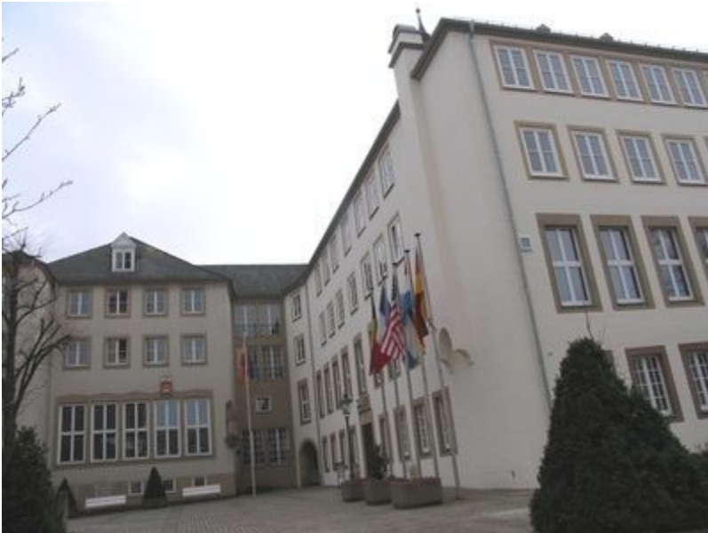
Im Rathaus selbst führt die Stadt in 2016 Brandschutzmaßnahmen durch
