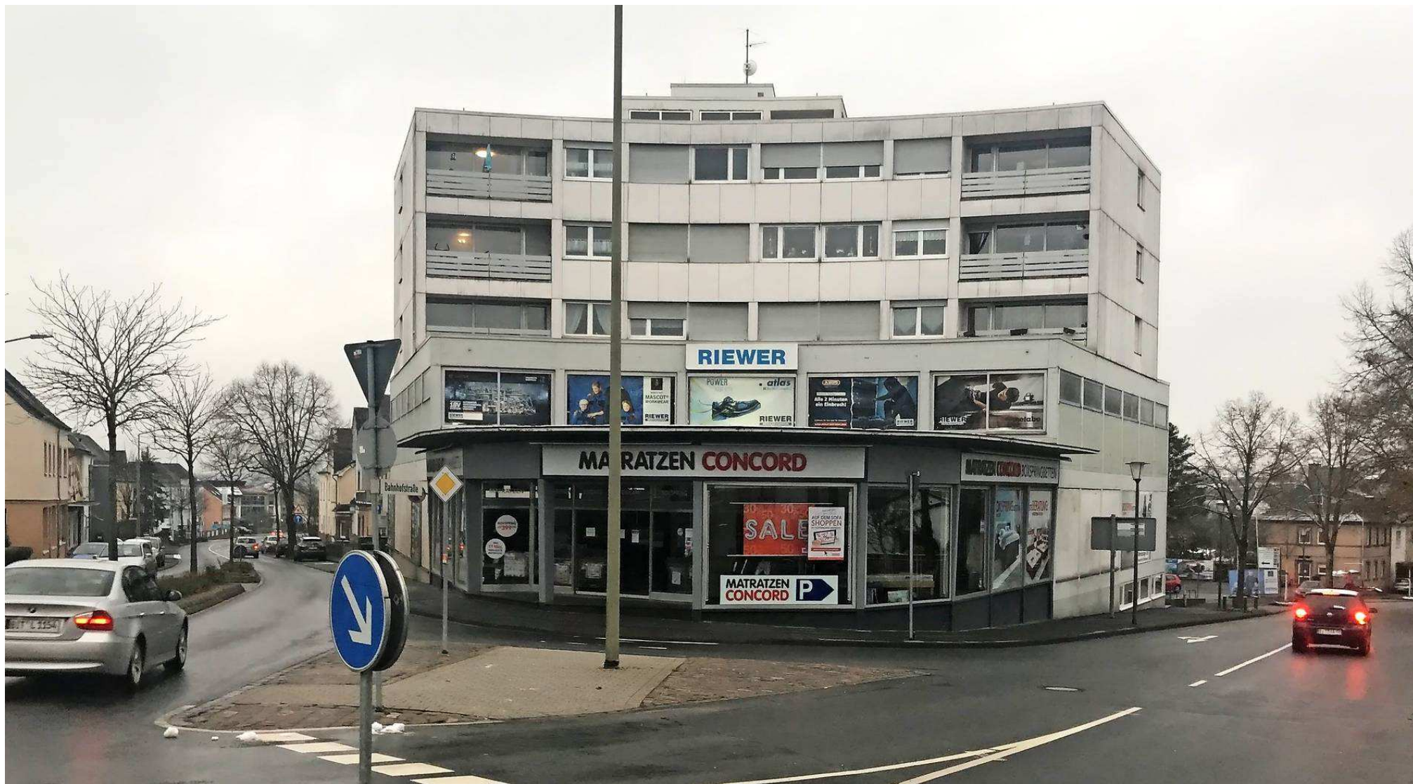
Das Gebiet zwischen der Mötscher Straße (links) und der Bahnhofstraße (rechts) soll städtebaulich überplant werden. Wie das genau aussehen wird, ist noch nicht sicher. Foto: TV/Uwe Hentschel
