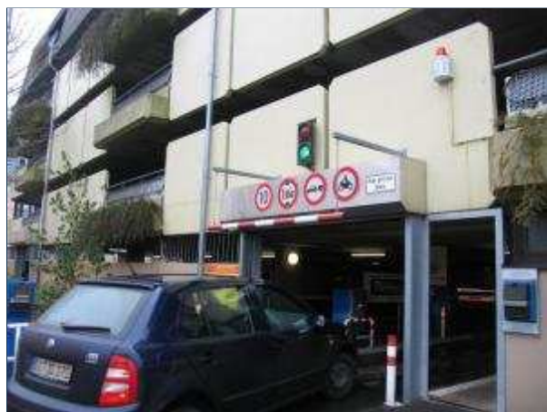
Kein Schmuckstück: Das Parkhaus Annenhof in der Bitburger Innenstadt ist sanierungsbedürftig. Foto: TV-Archiv
