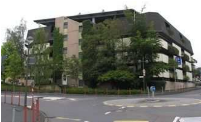
Parkhaus Annenhof in Bitburg
