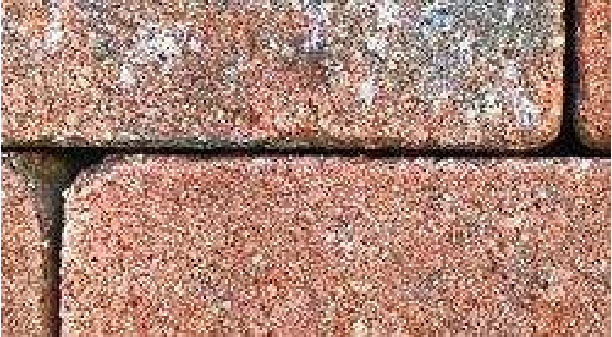
Mancher Bauherr hat mehr Fläche versiegelt als erlaubt. Foto: Tv/Uwe Hentschel
