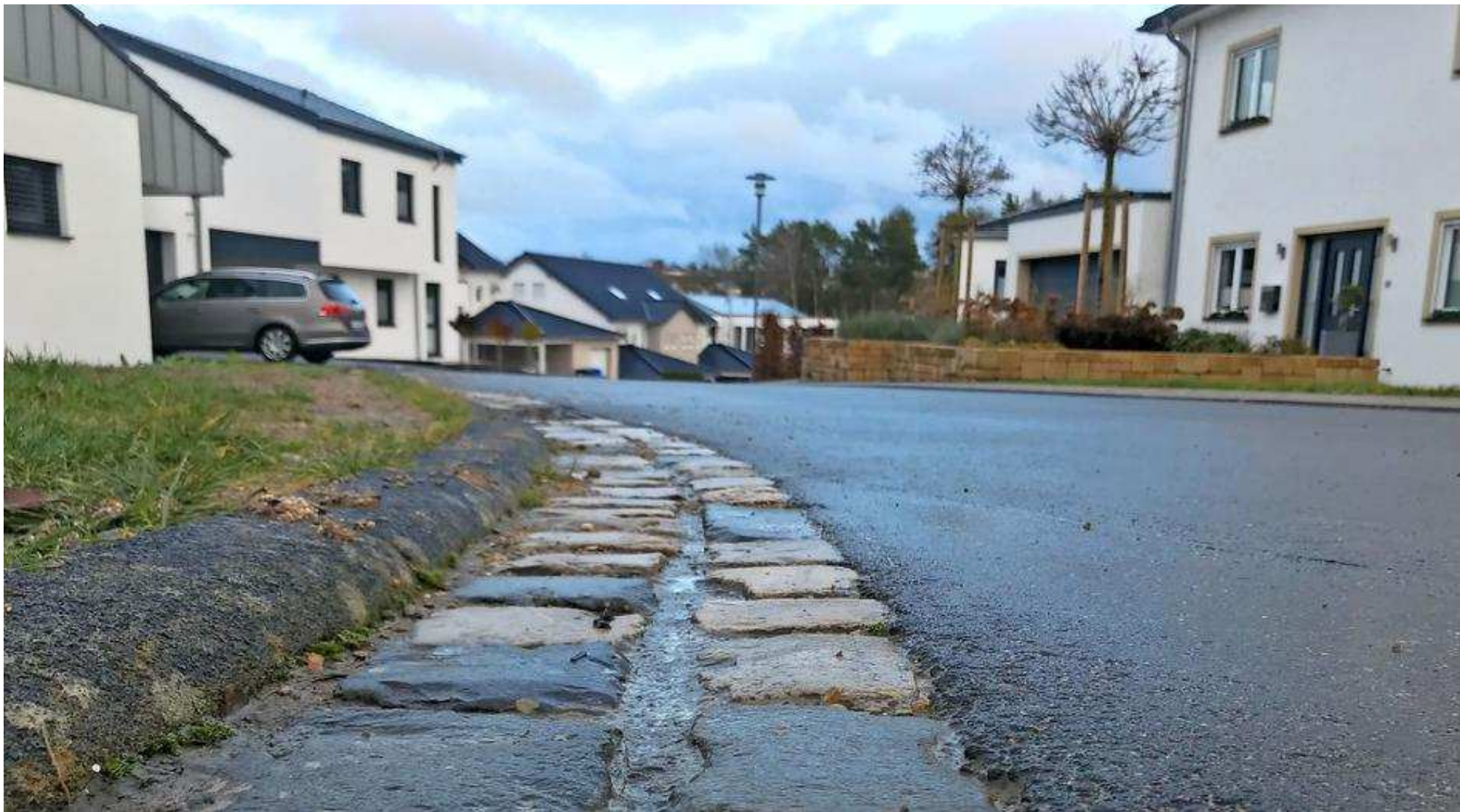
Die Straße am Dellbach im Stahler Neubaugebiet Hammerwies II ist im Eigentum der Stadt.
