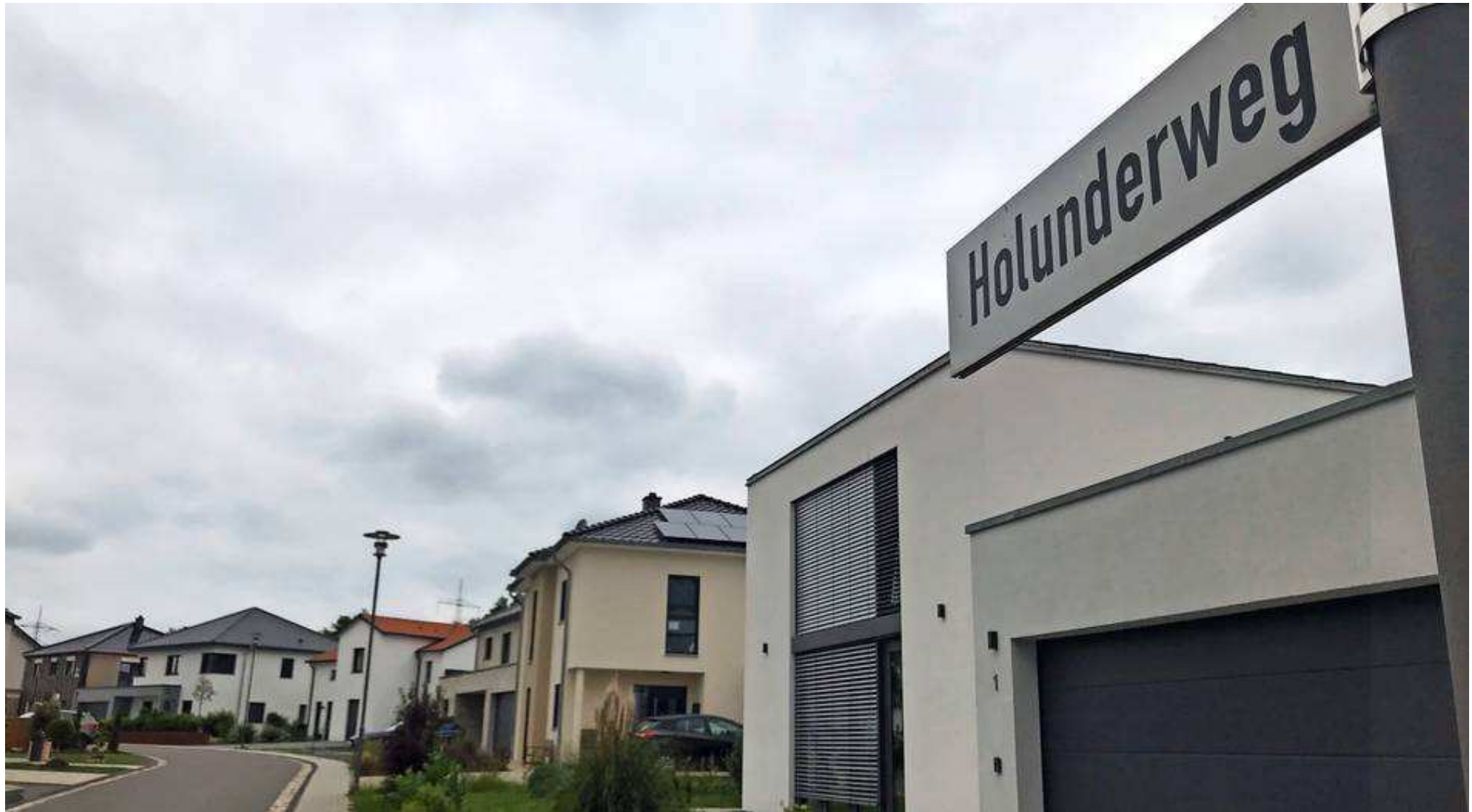
In den Stahler Neubaugebieten wurde in den vergangenen Jahren eifrig gebaut, in einigen Fällen aber etwas zu eifrig. Foto: TV/Uwe Hentschel
