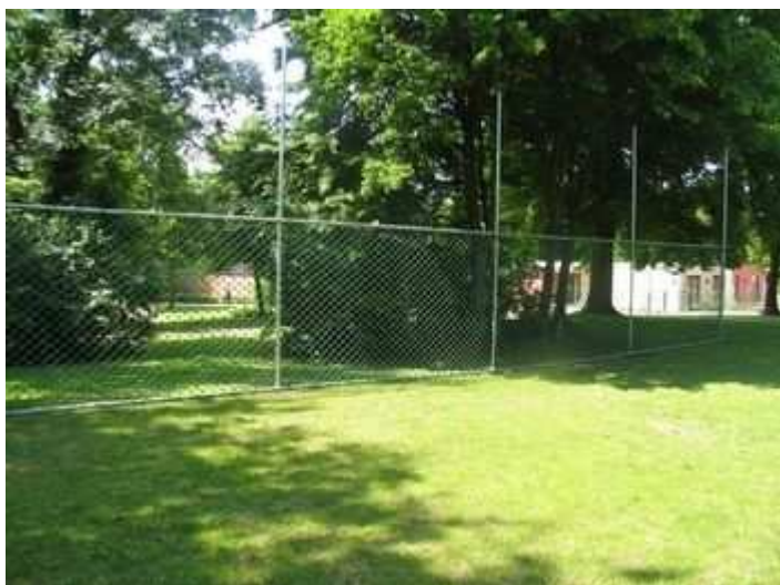
Der Ballfangzaun des neuen Bolzplatzes - im Hintergrund ist das Kita-Gebäude zu erkennen.
