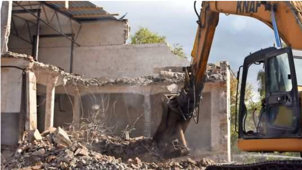
Bitburg Saarstraße Abriss Bauarbeiten FOTO: TV / Christian Altmayer
