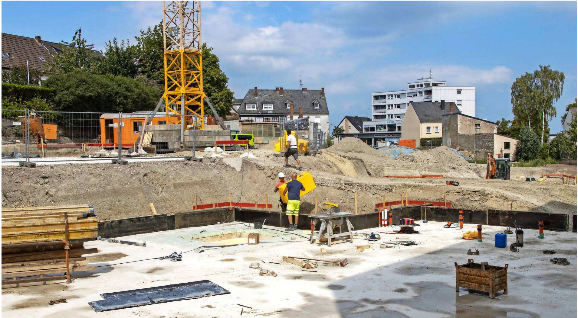
Noch Baustelle, bald Wohnpark: Blick auf den Bereich Saarstraße-Mötscher Straße in Bitburg. Foto: Rudolf Höser Foto: Rudolf HÄlser
