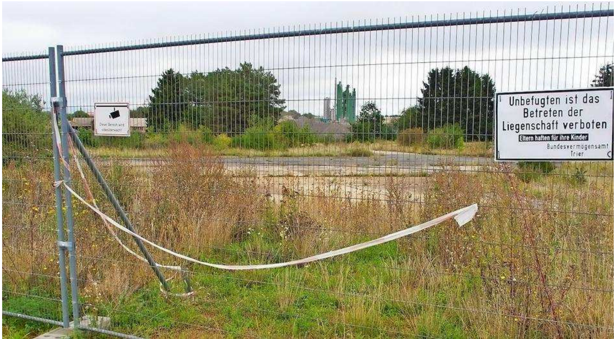
„Unbefugten ist das Betreten der Liegenschaft verboten“, steht auf dem Schild, das an einem Bauzaun neben der Erschließungsstraße hängt.
