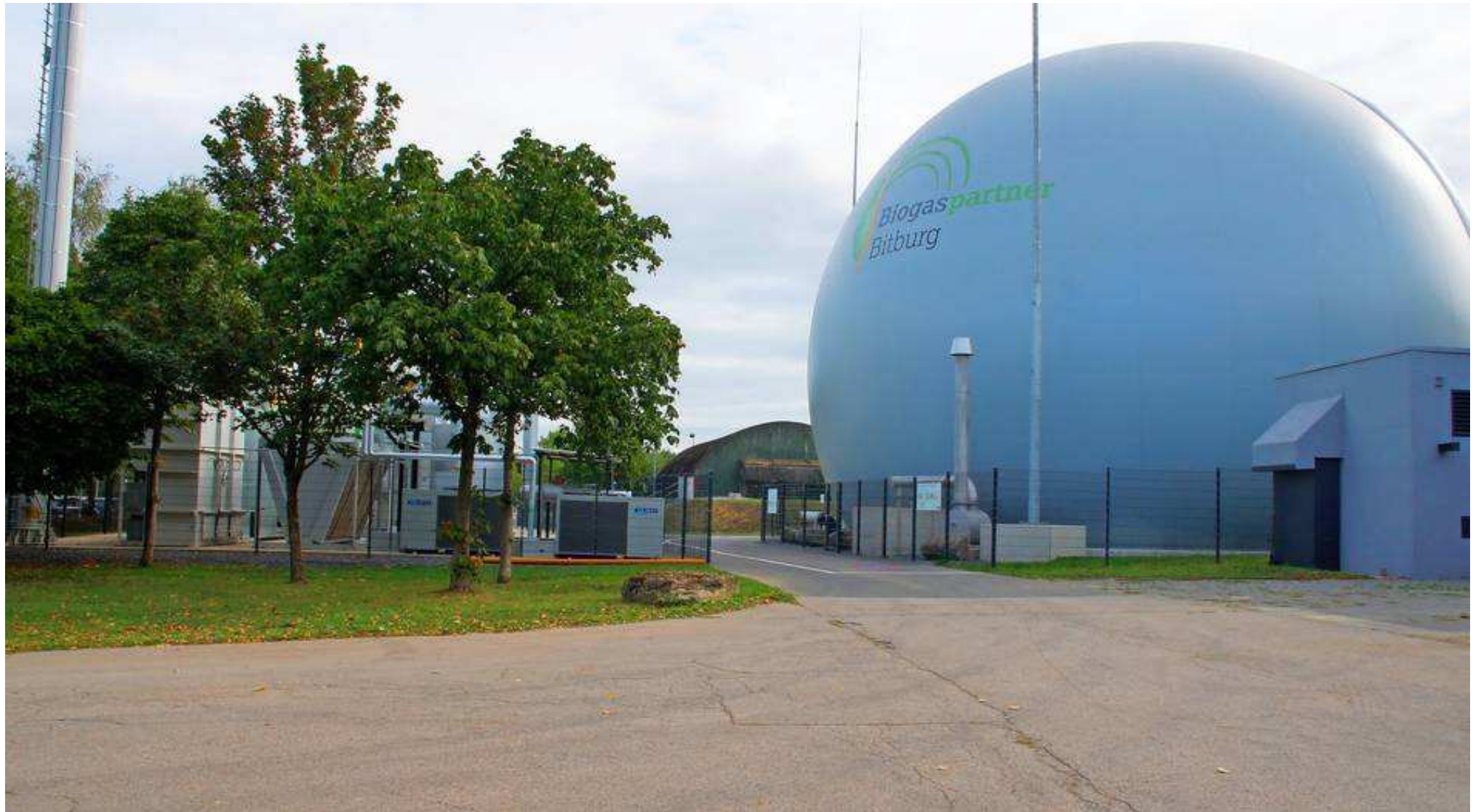
Bis zu 5300 Kubikmeter Rohbiogas können im Speicher der Anlage gesammelt werden. Foto: TV/Anja Theis
